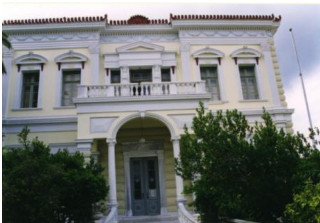
Κτίριο Εμπορικής Σχολής (Αίθουσες Διδασκαλίας Εισαγωγικής Κατεύθυνσης Μαθηματικών)
