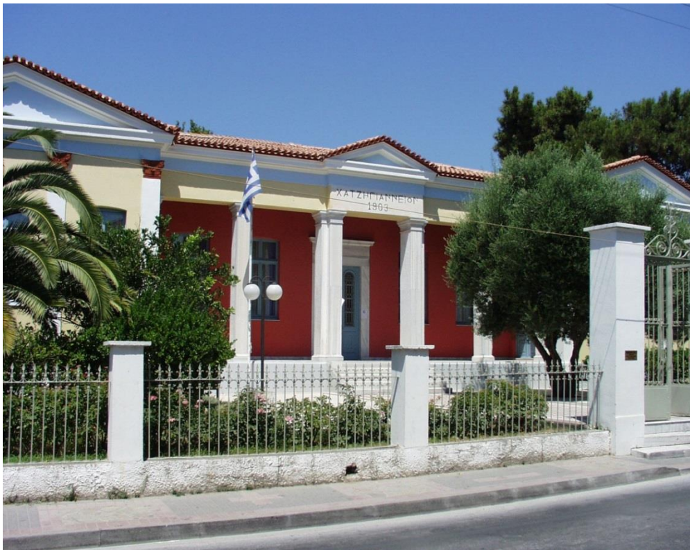
Χατζηγιάνναιο Κτήριο (Βιβλιοθήκη)
