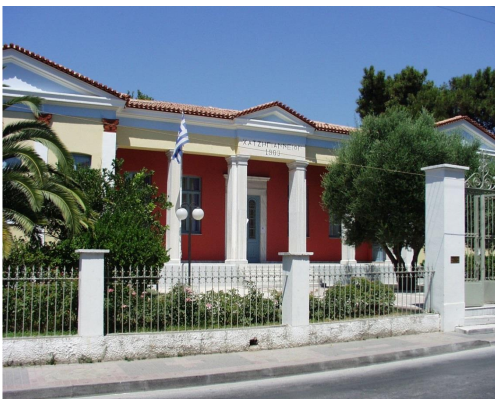
Χατζηγιάνναιο Κτήριο (Βιβλιοθήκη)
