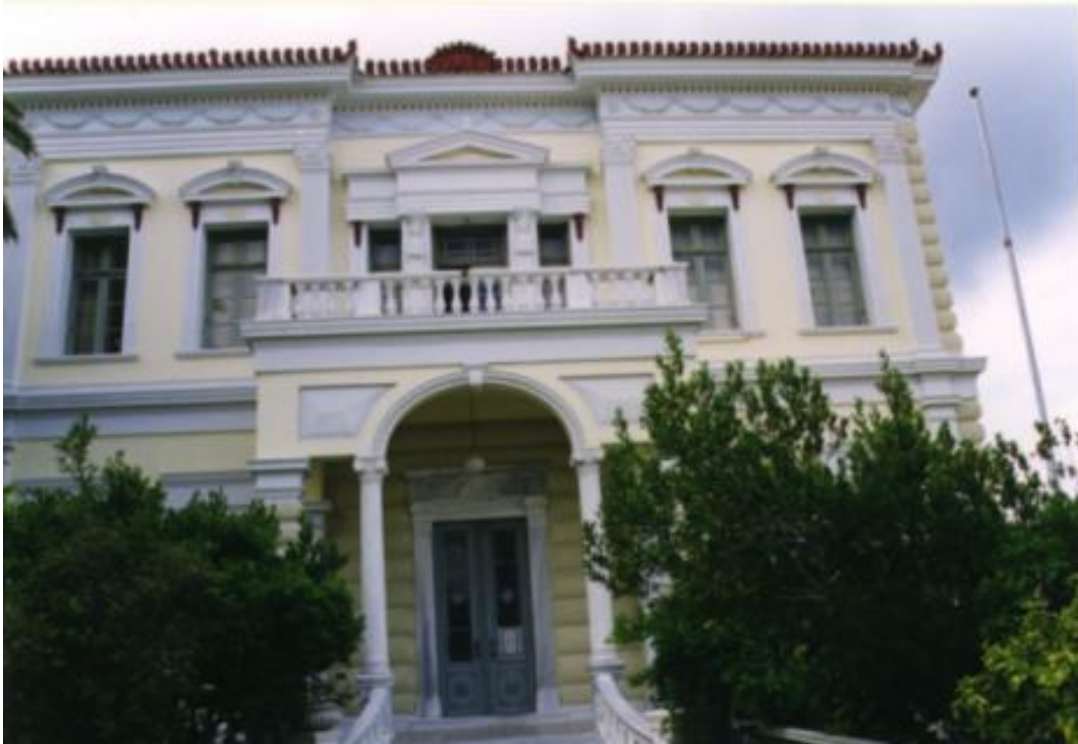
Κτήριο της πρώην Εμπορικής Σχολής (Αίθουσες Διδασκαλίας Τμήματος Μαθηματικών) (Προσωρινά μη προσβάσιμο λόγω βλαβών στο κτήριο από τον καταστροφικό σεισμό που έπληξε τη Σάμο τον Οκτώβριο του 2020. Αναμένεται η αποκατάστασή του.)
